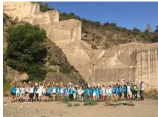
Salida de campo a la presa de Malpasse, destruida por una inundación en 1959
